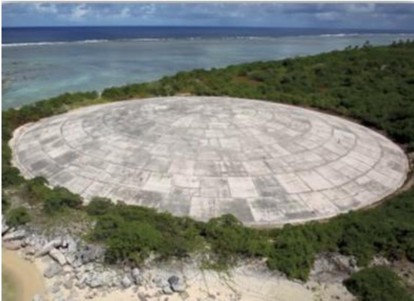
マーシャル諸島、エニウェトク環礁に作られた通称「ルニット・ドーム」。核実験でできたクレーター内に放射能を帯びた土砂や資材等を埋め、直径約110m、厚さ約50cmのコンクリートでドーム状に蓋をしている。近年劣化による放射能の漏洩の危険が指摘されている。（写真：アメリカ・エネルギー省）
